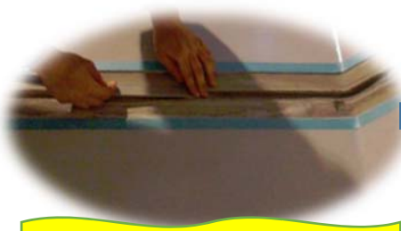
マスキング及びバックアップ材貼付
