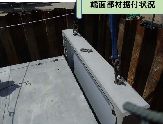
端面部材据付状況
